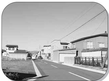
町道曙第二縦線、小沢中線、第二篠内線及び東老古美線の道路側溝整備工事を実施しました。(事業費6,441万円)
