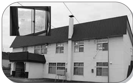
国富地区住民センター及び宮丘地区寿の家の窓枠改修工事を実施しました。(事業費896万円)
