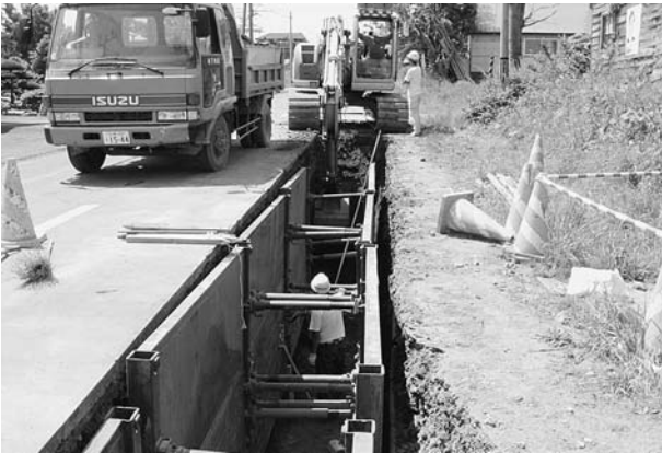
下水道（本管）工事の様子
