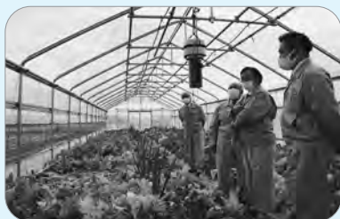
北海道原子力環境センター 農業研究科の試験による単管パイプを利用した園芸パイプハウスを確認
