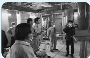
岩内・共和下水道管理センター 流量調整棟の設備等を確認
