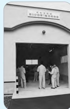
消防施設整備事業 建て替えた消防団機具格納庫(第5分団)を調査
