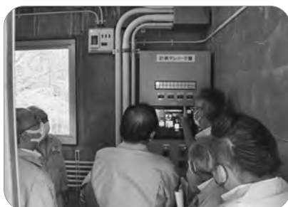
中平配水池系統漏水復旧状況
